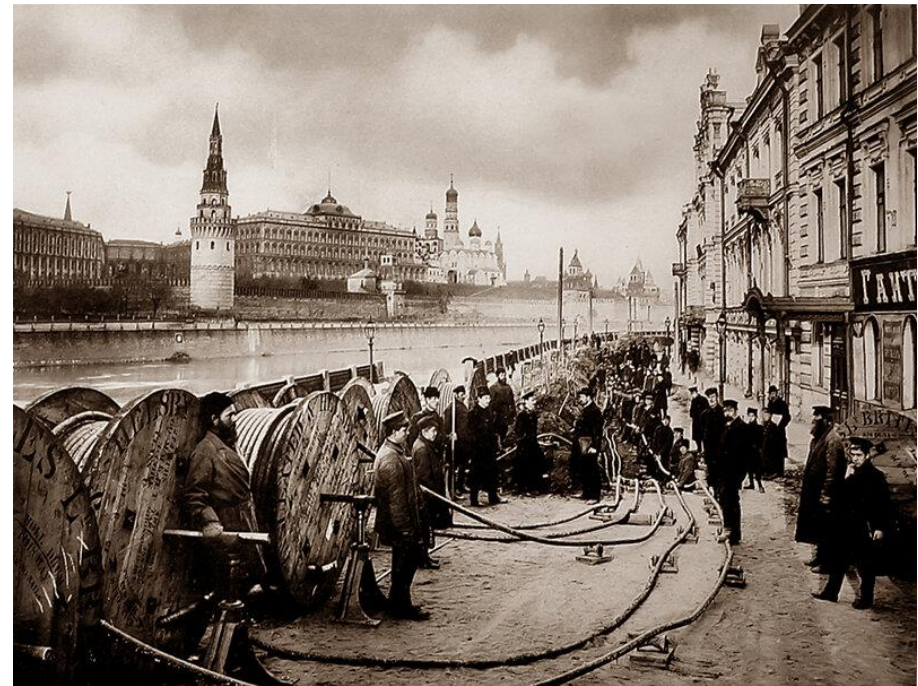
Укладка кабеля на улицах Москвы
