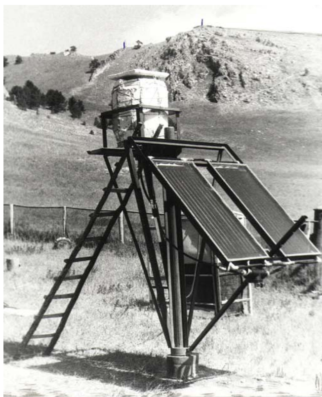
Рис. 2.20. Поворотный солнечный нагреватель мощностью 1,8 кВт конструкции ИСЗФ и СЭИ СО АН СССР.
